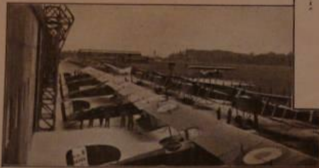
Vue de l'aéroport Latécoère à Toulouse
