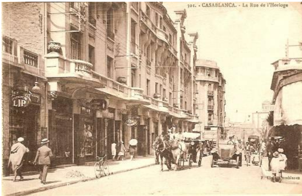
La rue des bureaux LATECOERE
